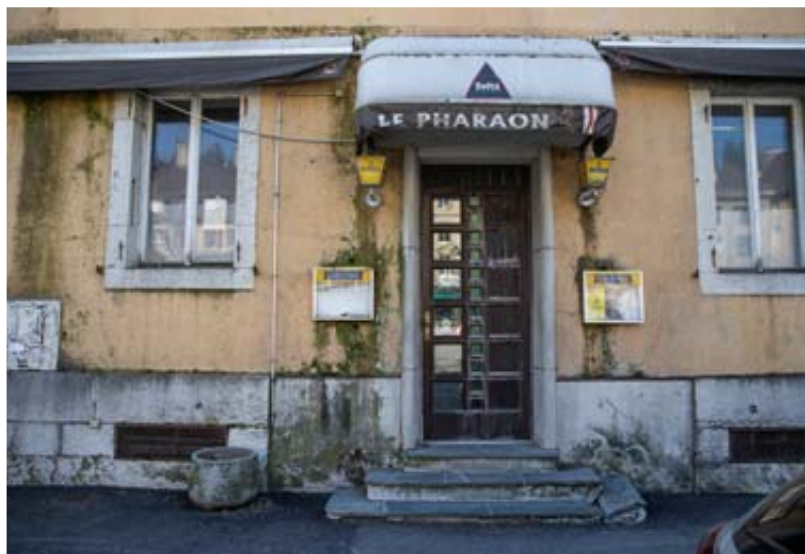
Laissé à l'abandon par son dernier propriétaire, une entreprise de construction vaudoise placée en liquidation en 2023, le bâtiment est devenu la honte de la place du Marché du Locle. MURIEL ANTILLE
