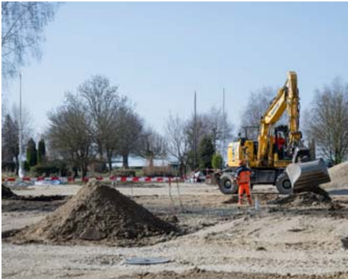
La première phase des travaux sera terminée en mai prochain. Le village lacustre, sur l'île, sera terminé un an plus tard, en mai 2027.
