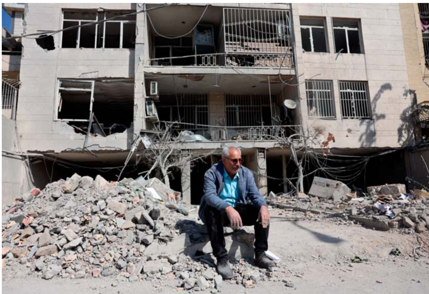
Un Iranien assis à côté des décombres de son immeuble résidentiel dans le centre de Téhéran. KEYSTONE/EPA/ABEDIN TAHERKENAREH
