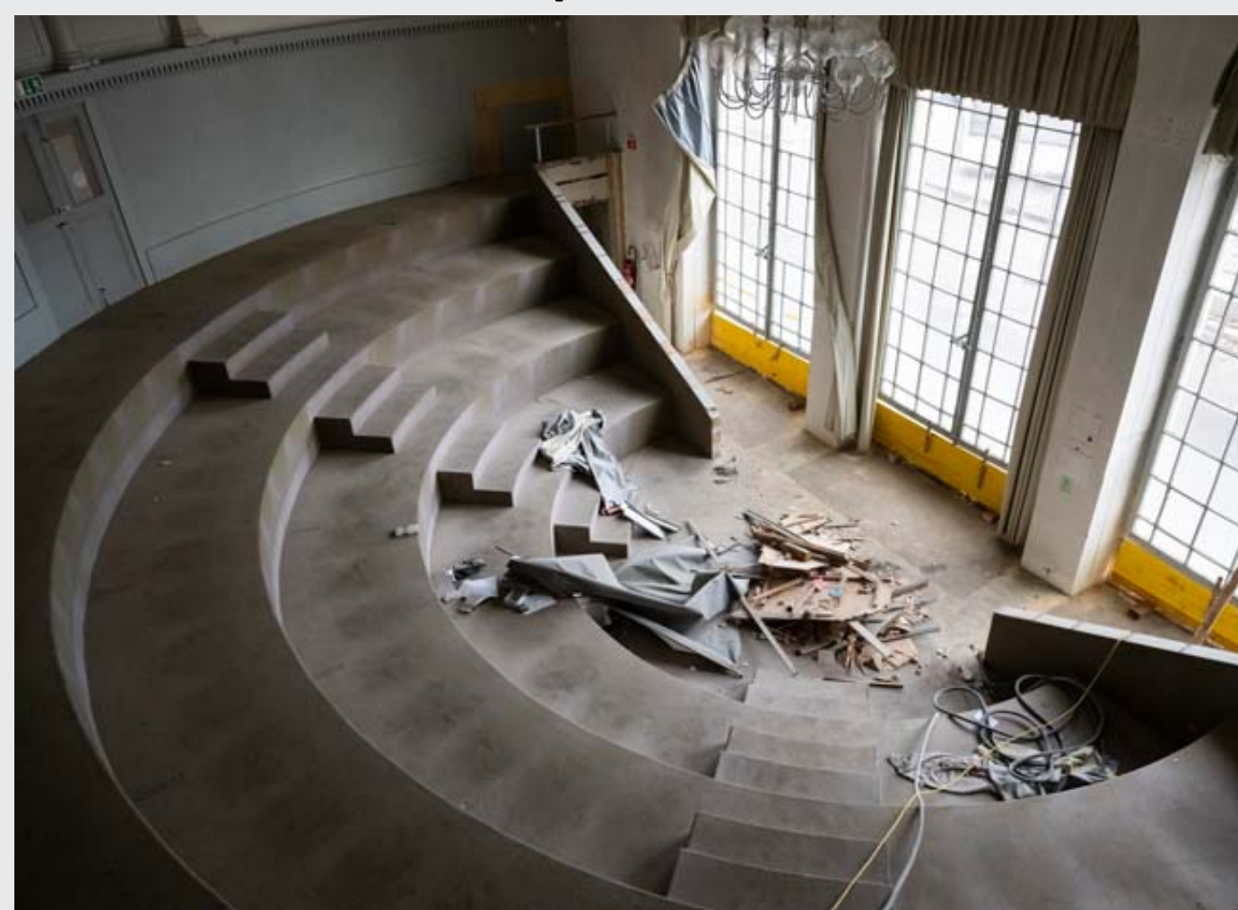
Une vue des travaux au Collège latin, en décembre dernier. LUCAS VUITEL
