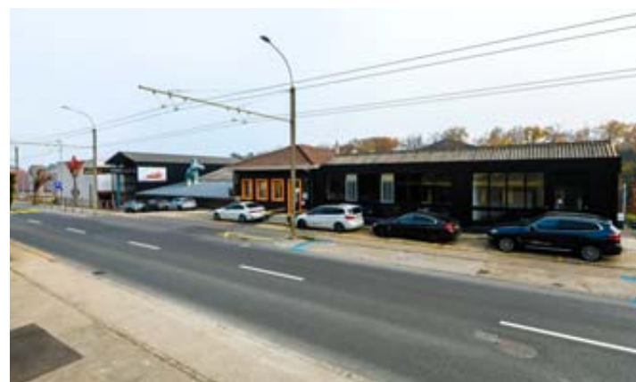
Cette photo (qui date d'avant les travaux de réaménagement routiers en cours) montre où s'élèveront les deux immeubles. CHRISTIAN GALLEY
