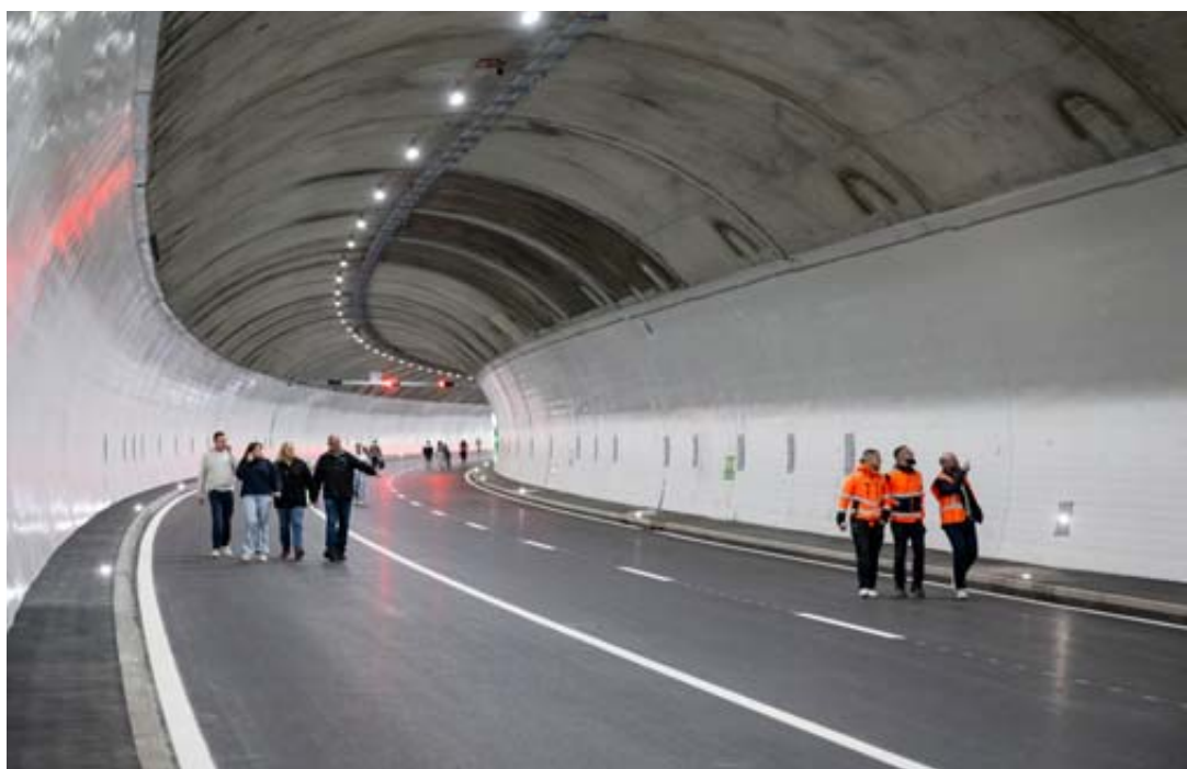
Hier, de 11h à 15h, le public pouvait se balader tranquillement à travers l'ouvrage.
