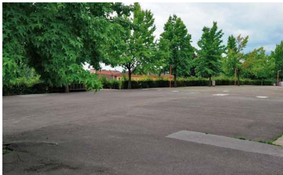
La cour du collège des Guches attend d'être réaménagée. SP - VILLE DE NEUCHÂTEL
