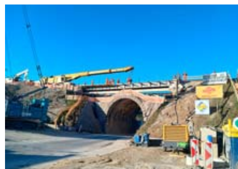
De manière à pouvoir démolir l'ancien ouvrage et construire le nouveau pont sans interrompre le trafic ferroviaire, un pont métallique provisoire a été posé en octobre 2024. SP - SPCH
