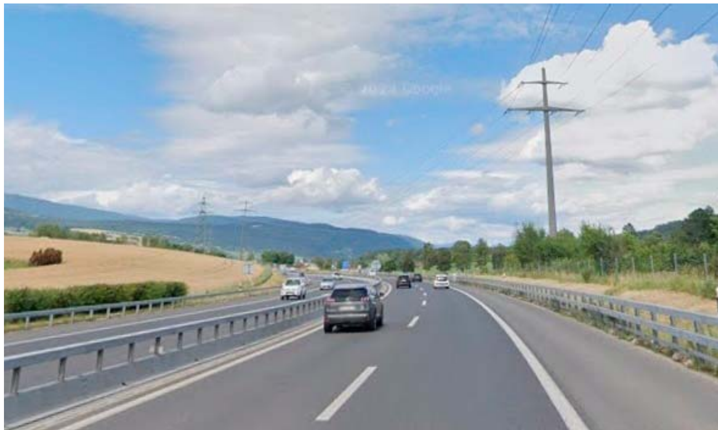
La collision s'est déroulée dans une légère courbe à gauche, sur la chaussée autoroutière menant à Bienne. CAPTURE D'ÉCRAN: GOOGLE STREETVIEW
