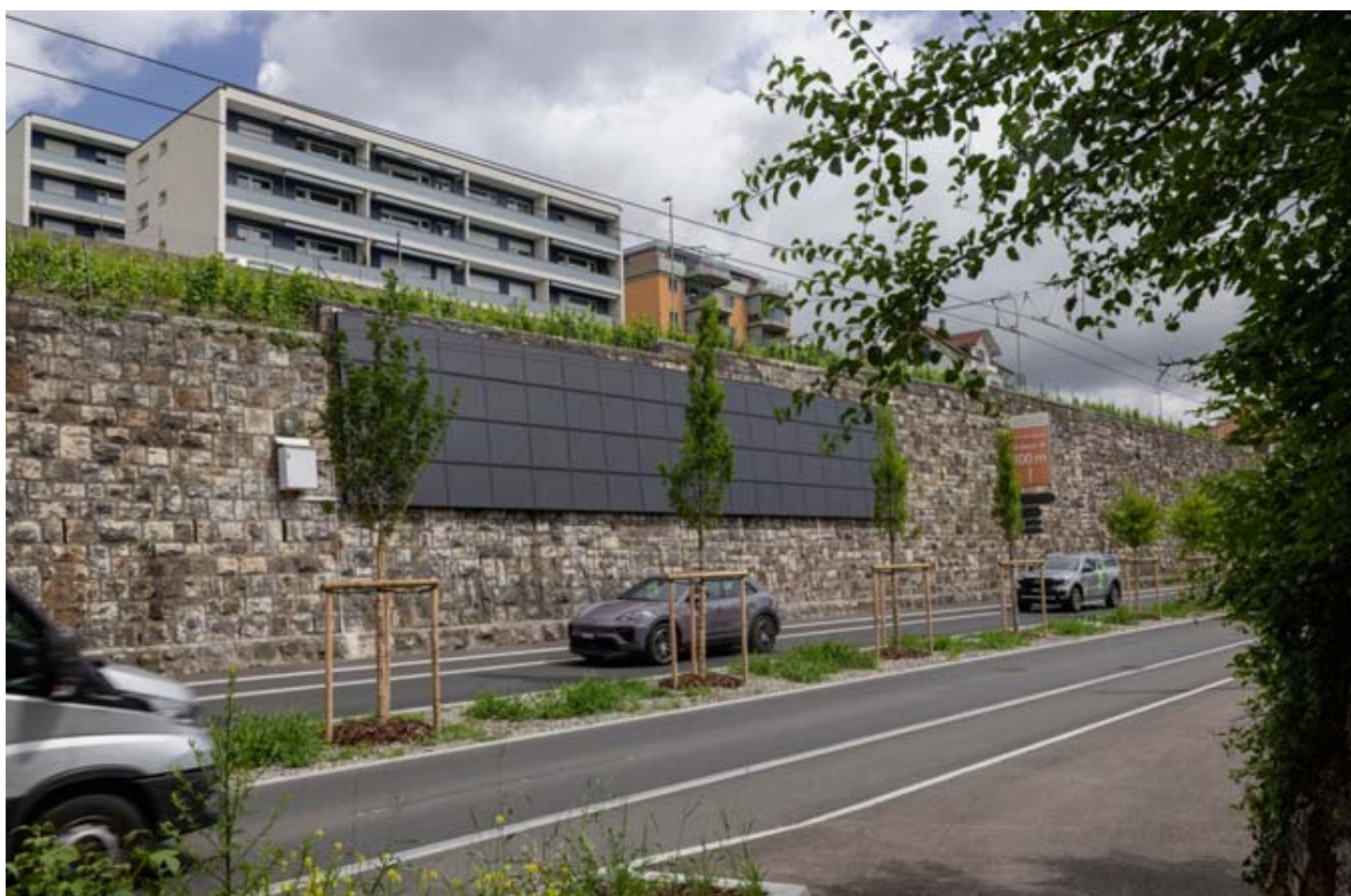
Des modules solaires innovants viennent d'être posés le long de la route cantonale, aux Rouges-Terres à Hauterive. MURIEL ANTILLE
