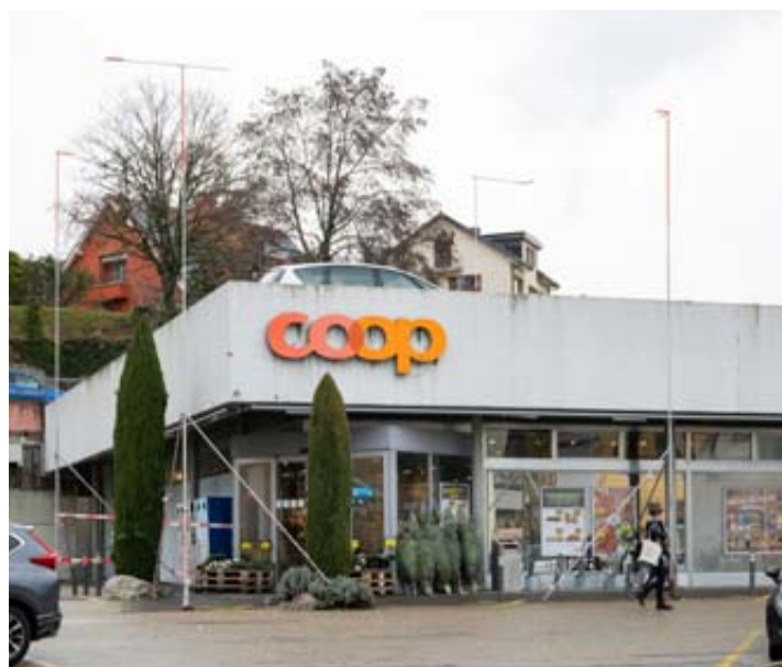
Un ascenseur et une cage d'escalier seront construits entre le magasin et le parking situé sur la toiture. Ici une photo lors de la mise à l'enquête du projet. LUCAS VUITEL
