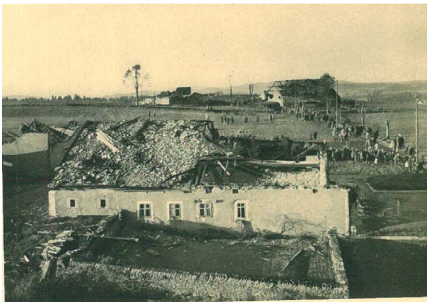
Au Valanvron, de nombreuses fermes ont subi des dégâts, le samedi 12 juin 1926. F. HAEFELI
