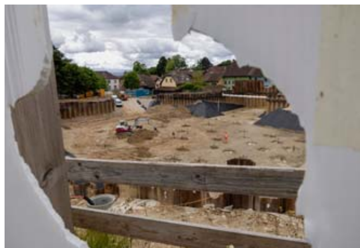
Le chantier a commencé en juillet passé. MURIEL ANTILLE
