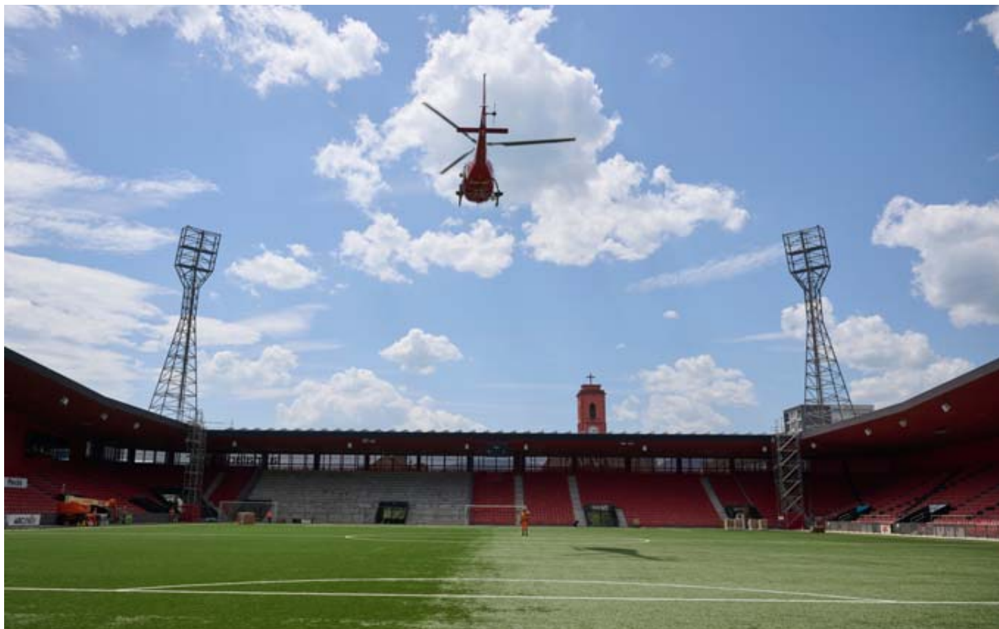
L'hélicoptère a déposé du matériel sur le toit des tribunes, au pied de chacun des quatre projecteurs, qui ont déjà été débarrassés de leurs anciens luminaires. DAVID MARCHON
