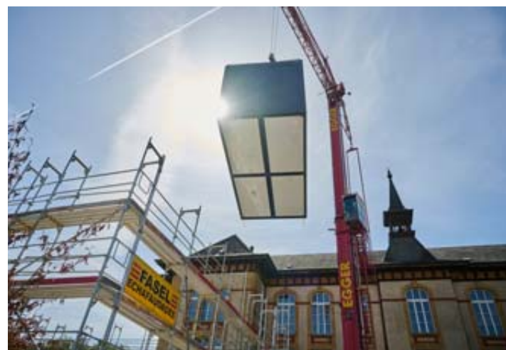
Avec pour cadre le collège historique de Boudry, la pose des conteneurs à l'aide d'une grue est une opération spectaculaire. DAVID MARCHON
