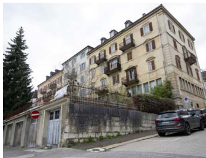
Pollué, l'immeuble est interdit d'accès depuis 2013. LUCAS VUITEL
