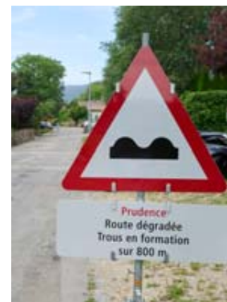
Refusé en novembre, le crédit pour la réfection de la route des Esserts a passé la rampe ce lundi. DAVID MARCHON
