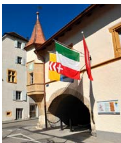
La Maison Vallier, à Cressier, est un bâtiment protégé. Pas facile d'y ajouter une issue de secours. SNP
