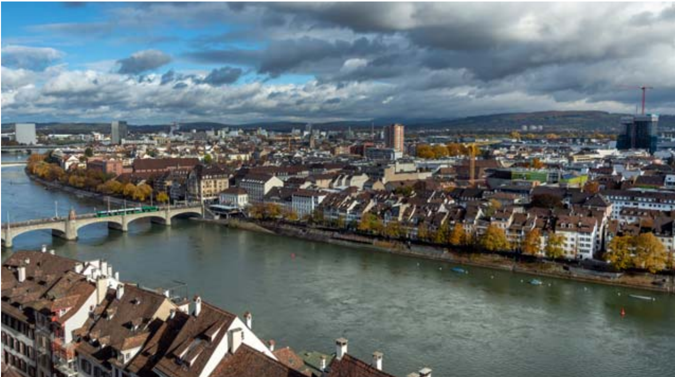
Deux tours de refroidissement installées sur le toit d'un immeuble de bureaux de la Rebgasse, dans le Petit-Bâle (photo), sont considérées comme la source la plus probable des infections. KEYSTONE/GEORGIOS KEFALAS
