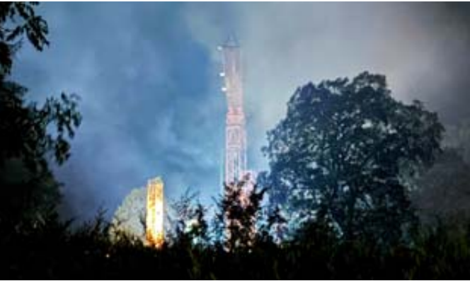
De grosses fumées s'élevaient à l'ouest de la route de Sombacour autour de grues de chantier, lundi soir. FRANÇOISE KUENZI
