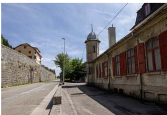
La tour avait comme unique fonction d'accéder à une passerelle qui enjambait les voies de chemin de fer, alors situées rue des Eroges.
