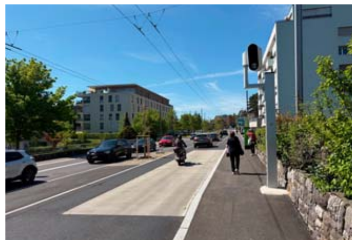
Après réfection d'une portion partant de Monruz, le chantier de rénovation de la RC5 se déplace plus à l'est pour deux ans. PASCAL HOFER
