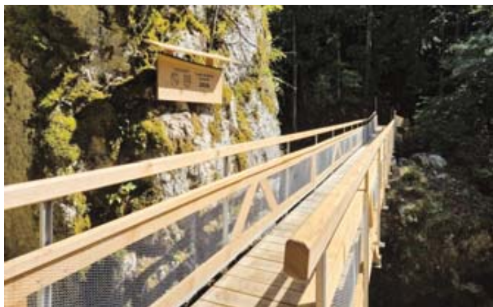
La première passerelle, flambant neuve, a été installée en 2026, en remplacement de l'ancienne. BAPTISTE GONSETH
