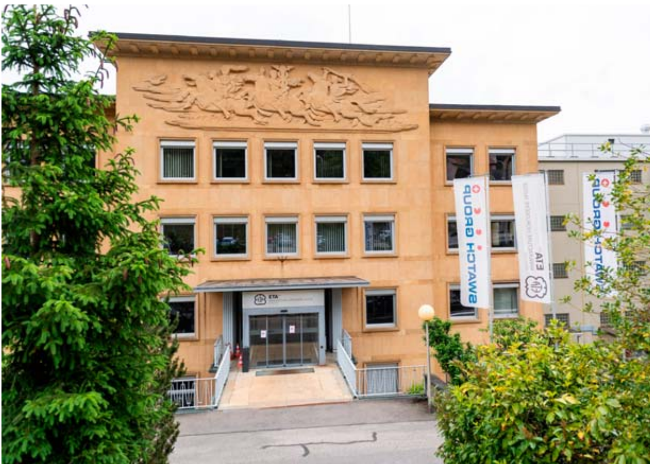
L'actuelle usine d'ETA à Fontainemelon a été, avec des usines de Granges, à l'origine d'Ebauches SA il y a 100 ans. ARCHIVES LUCAS VUITEL
