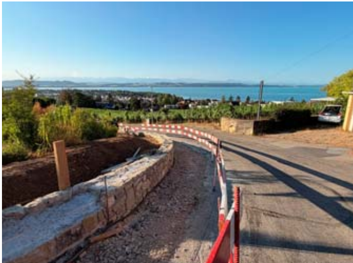
Plusieurs murs de pierres ont été démolis puis reconstruits pour permettre l'élargissement du chemin. VIRGINIE GIROUD
