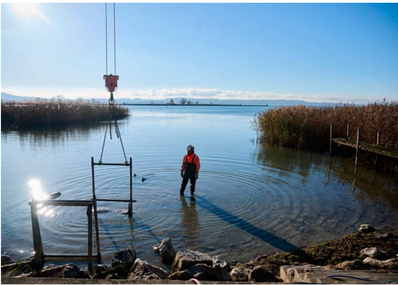
En novembre 2025, la Commune de Laténa démontait les pontons de la Tène, construits sans autorisation dans les années 1950. Cette démolition doit être régularisée. DAVID MARCHON
