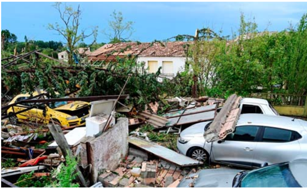
La tornade a endommagé les habitations, retourné des voitures et arraché des arbres. KEYSTONE/MAXPPP/BOYER
