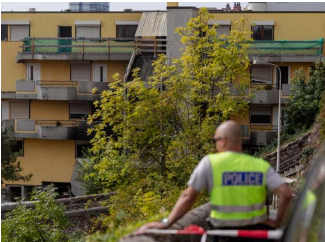
L'immeuble dans lequel a eu lieu l'explosion, il y a une semaine, restera inhabitable, le temps que d'importants travaux de rénovation soient menés. MURIEL ANTILLE
