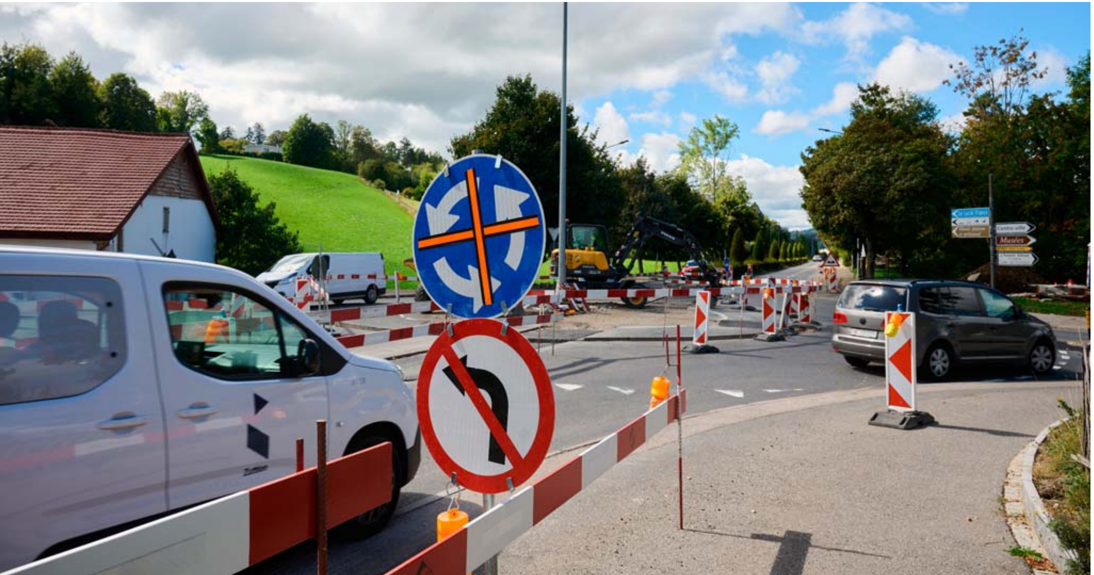
Des travaux ont lieu sur d’importants axes routiers chaux-de-fonniers, comme ici sur le boulevard de la Liberté.
