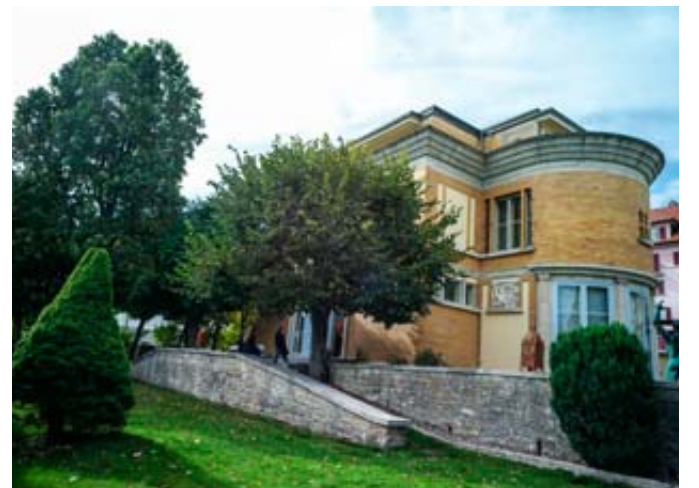
La villa turque, œuvre du Corbusier, avait été acquise par Ebel en 1987. Elle devrait rester dans le portefeuille de ses nouveaux propriétaires. ARCHIVES CHRISTIAN GALLEY
