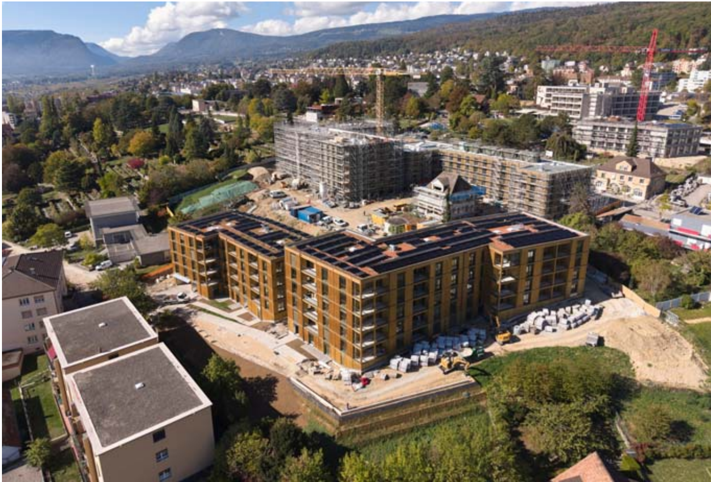
Cette vue aérienne montre les quatre nouveaux bâtiments avec, au centre, une ancienne maison (la villa Matile) qui a été conservée et rénovée.
