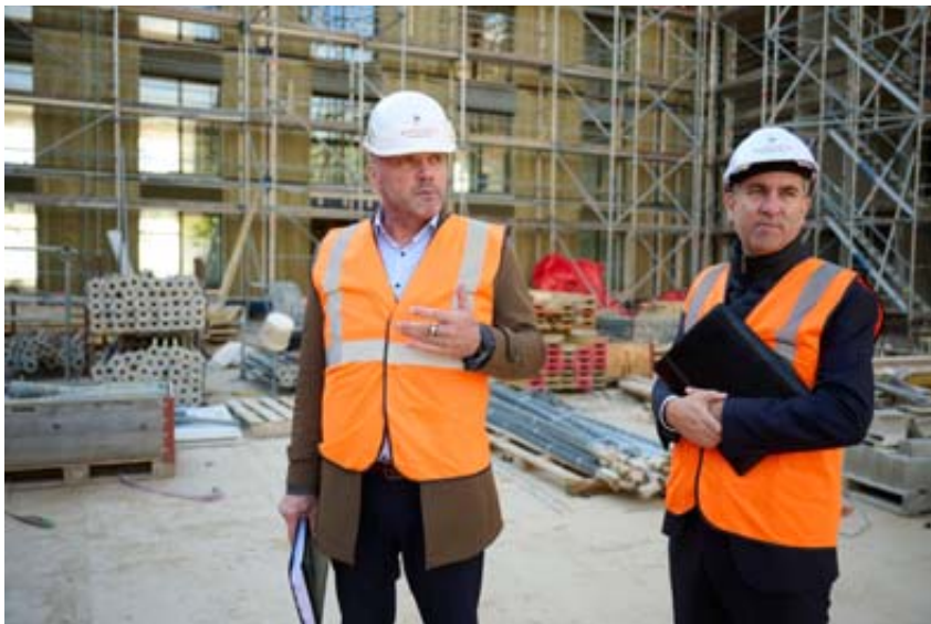
Christian Cottet, responsable constructions et rénovations de Bonhôte-Immobilier (à gauche) et le nouveau responsable du fonds, Mirko Mandola, ont guidé «ArcInfo» à travers les travaux du complexe B.180, à Beauregard.
