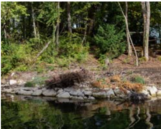
L'un des quatre enrochements créés sur la rive gauche de l'Areuse.
